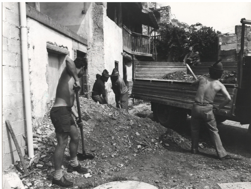
Alpini al lavoro dopo il terremoto del Friuli del 6 maggio 1976
