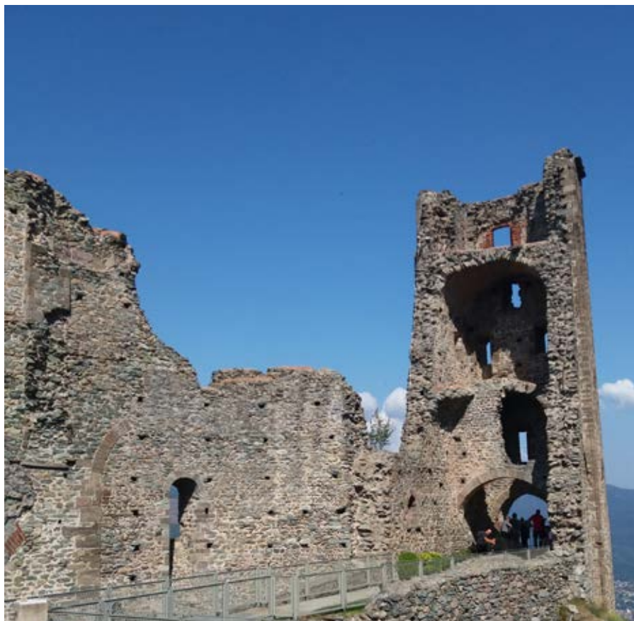
La torre della Bell'Alda da cui secondo la leggenda una fanciulla si gettò per sfuggire ai soldati che la inseguivano invocando la Madonna. Salvata dagli angeli ritentò il volo, morendo però sulle rocce sottostanti
