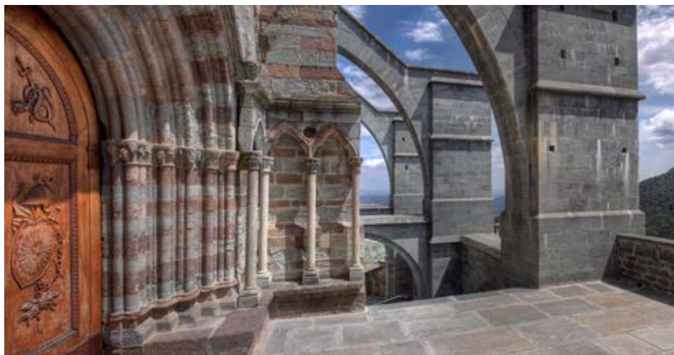
La soglia del portale della Chiesa con gli archi rampanti di Alfredo D'Andrade
