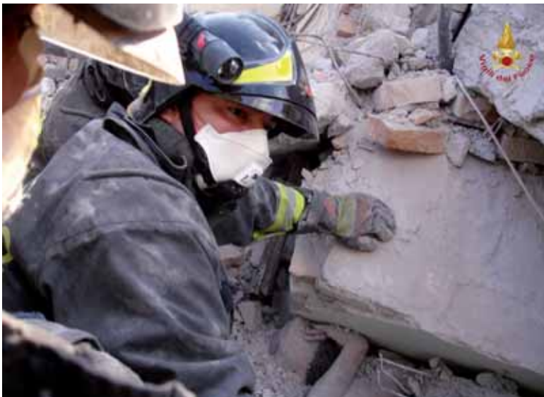
Intervento tra le macerie dopo un crollo.
