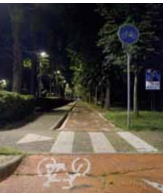
Pista ciclabile Corso Duca degli Abruzzi Torino Appare sufficientemente illuminata e visibile
